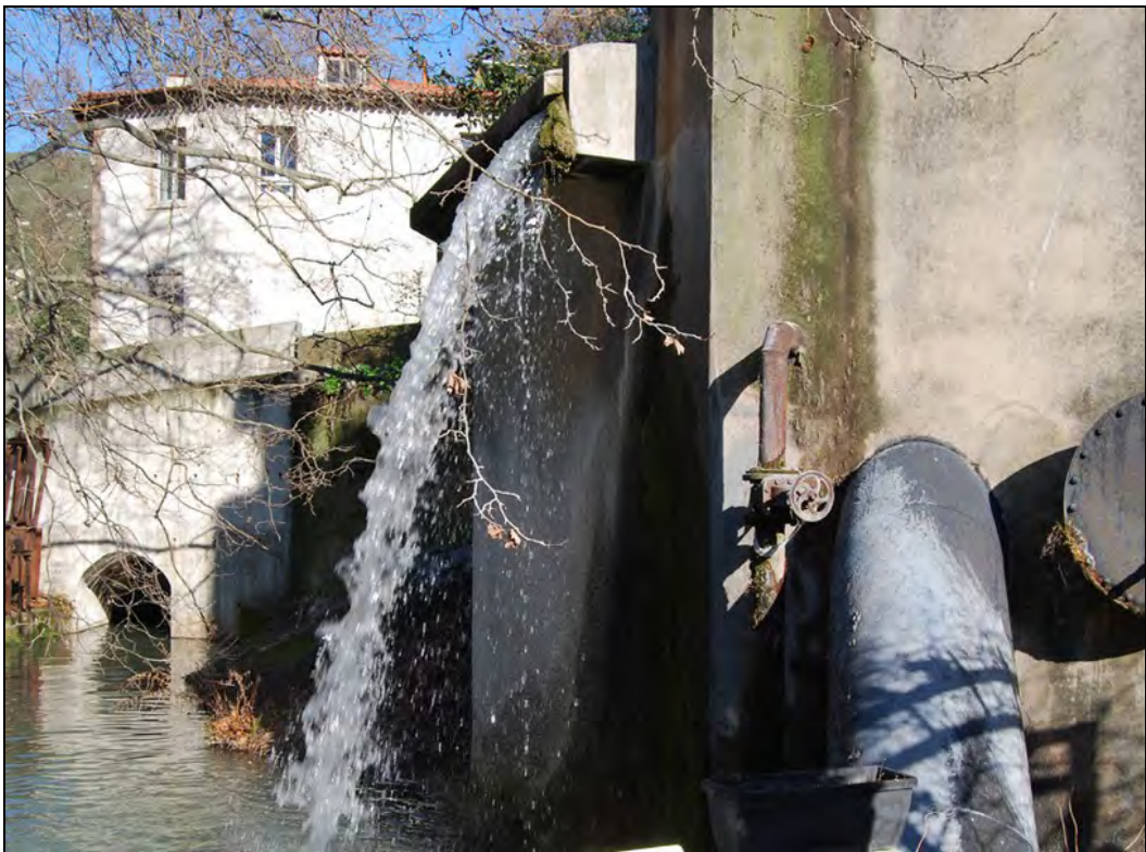
L'eau arrivant à l'étage supérieur emprunte la conduite visible à droite et fait une chute de 4m sur l'une des turbines de la papeterie. Une 2 ème conduite, ici fermée, accédait à une 2 ème turbine qu'on a cessé d'utiliser.
