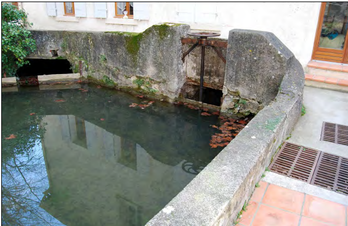
Arrivée du béal sur la minoterie du Pont de Joux. Sur la droite de la martellière on remarque deux grilles. Elles recouvrent les prises de 2 conduites en terre cuite qui se rendaient l'une vers un bassin alimentant le réservoir de la gare d'Auriol, l'autre vers les terres à l'arrosage des Delestang.
