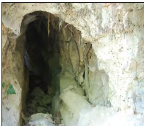
Aperçu d'une portion du béal creusé dans le tuf.
