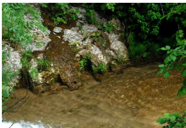
Ces encoches dans la roche, au dessous de la 1 ère resclave du Vallon témoignent de l'implantation d'une resclave, anciennement emportée par une crue. (A gauche, sur la rive droite, à droite, sur la rive gauche).
