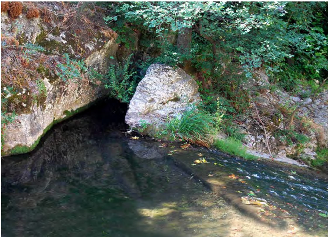
Le départ, taillé dans le roc, du béal de la rive gauche. On distingue, sur la droite, une portion de la resclave.
