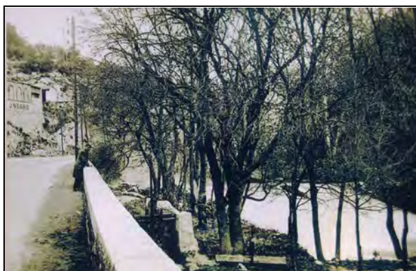
Carte postale de 1920 environ montrant la resclave du moulin de St Claude à droite et, contre la route, le béal avec sa martellière, aujourd'hui disparus.
