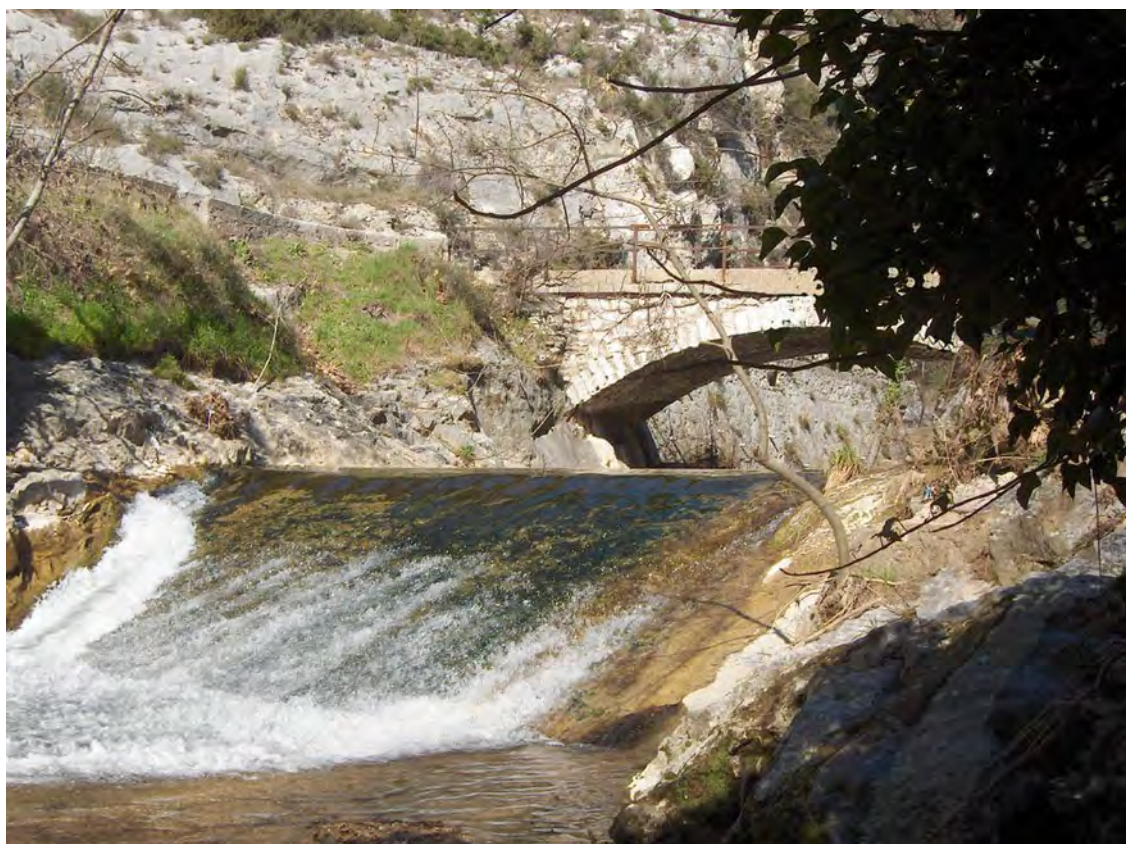
plan incliné de la resclave donnant le béal de la rive gauche, au-dessous du pont de l'usine du Vallon, tel qu'on peut le voir de nos jours.
