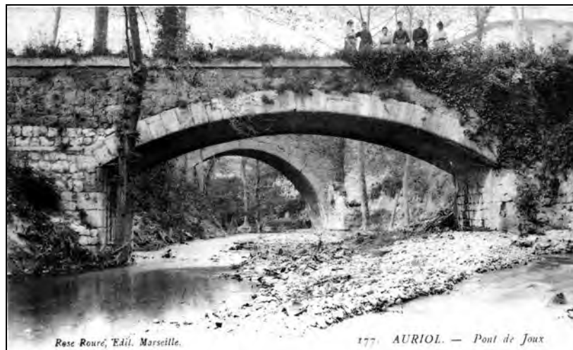
Vu de l'aval, le pont aqueduc qui conduit une partie de l'eau du béal vers le château et son parc. Au fond la voûte du pont de Joux.
